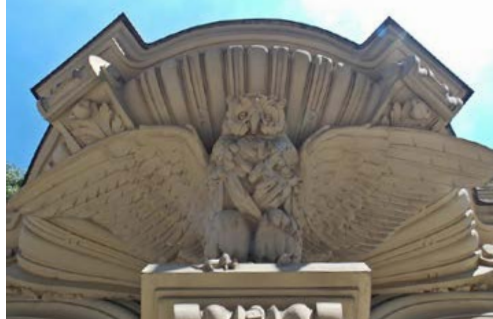
Il. 28. Odtwarzanie detali architektonicznych podczas kompleksowych remontów kamienic, źródło: Miasto Tysiąca Kamienic.
