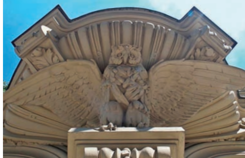
Il. 30. Odtwarzanie detali architektonicznych podczas kompleksowych remontów kamienic, źródło: Miasto Tysiąca Kamienic.
