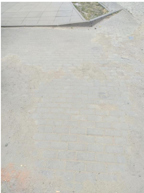
Zdjęcie 6. Krawężnik przy wjeździe na teren Domu od strony ul. Wółczańskiej [10 lipca 2018 r.].
