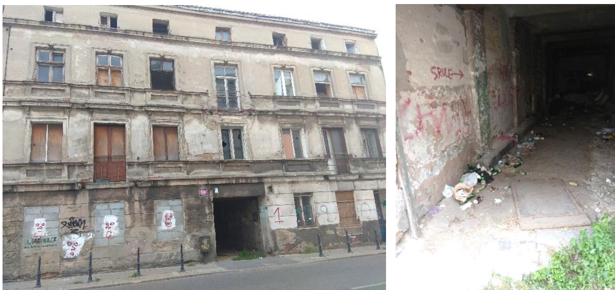
Zdjęcie 17. Opuszczona kamienica przy ul. Wólczańskiej 156 i widok bramy [10 lipca 2018 r.].
