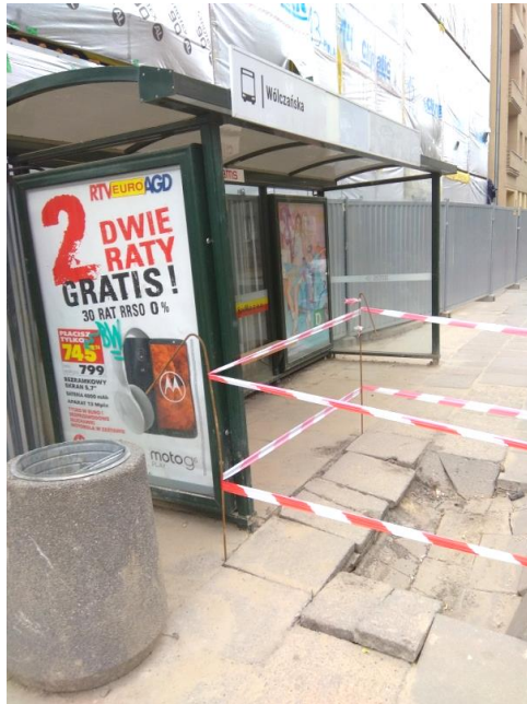
Zdjęcie 99. Chodnik przy przystanku na ul. Radwańskiej przy Szpitalu im. Pirogowa [10 lipca 2018 r.].
